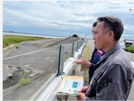
■尾張大橋にて令和4年度に実施した整備の効果を現地にて確認
