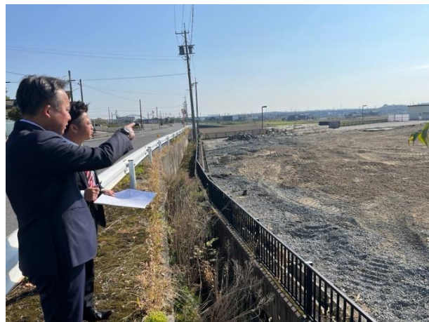
■保々ふれあい会館跡地の視察(2022.11.13) 四日市市議の谷口周司先生と解体現場を視察し、今後の活用方法を協議しました。
